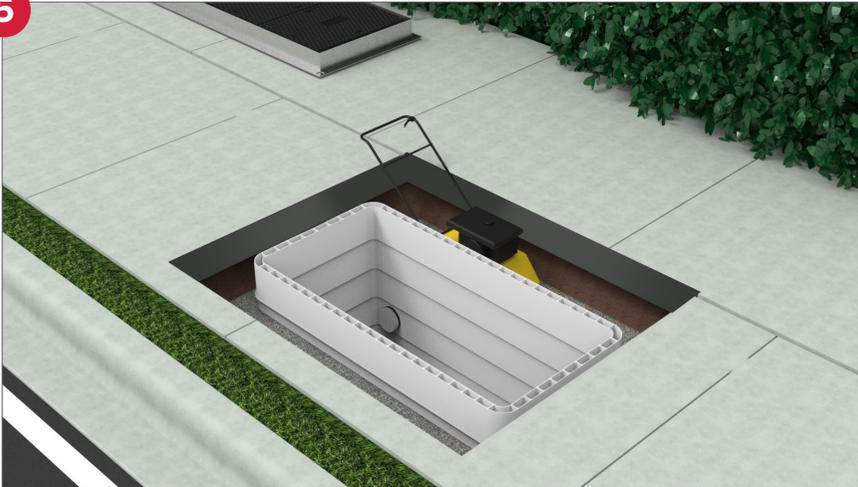
Füllen Sie die Grabenfüllung in 300-mm-Intervallen auf, verwenden Sie dazu einen Rüttelplatte oder einen Handstampfer."
