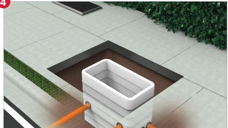
Führen Sie die Rohre durch die vorgefertigten Rohreinführungen ein
